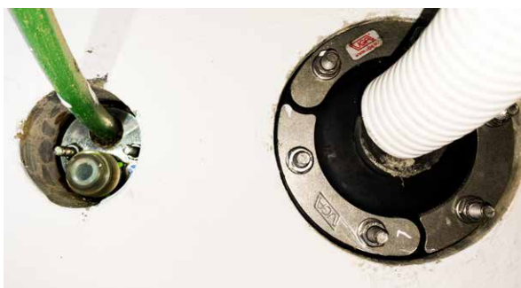
Abbildung 24: Einspartenhauseinführung für einen bzw. zwei Netzbetreiber
