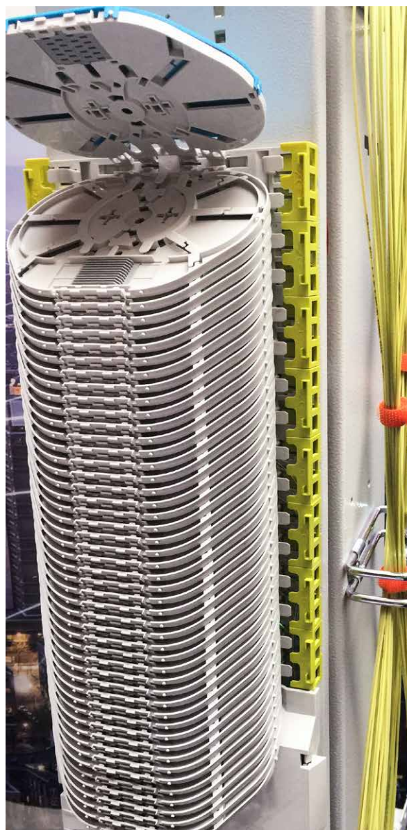
Abbildung 38: Einzelfaser-Management am GF-AP für eine PtP-Verbindung
