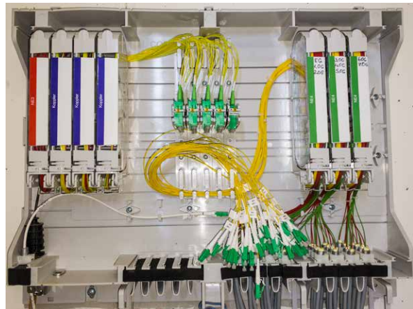
Abbildung 44: HFC-Gebäudeverteiler mit darüberliegendem Kabelführungssystem/Kabelwanne
