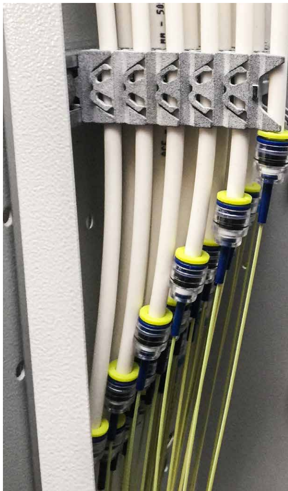
Abbildung 39: Darstellung der Installationsleitung zu den WÜPs
