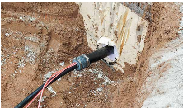
Abbildung 28: Mehrspartenhauseinführung an der Gebäudeaußenwand
