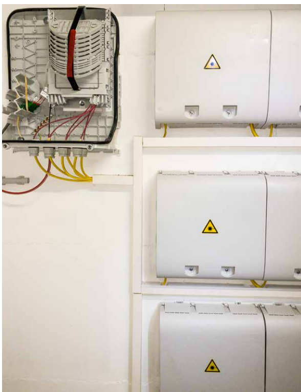
Abbildung 37: GF-AP für eine PON-Verteilung
