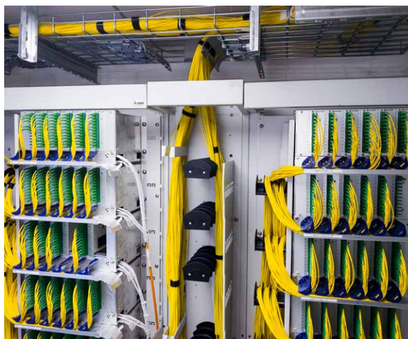
Abbildung 52: Einzelkabel-Management zur Anbindung der WE (FTTH)
